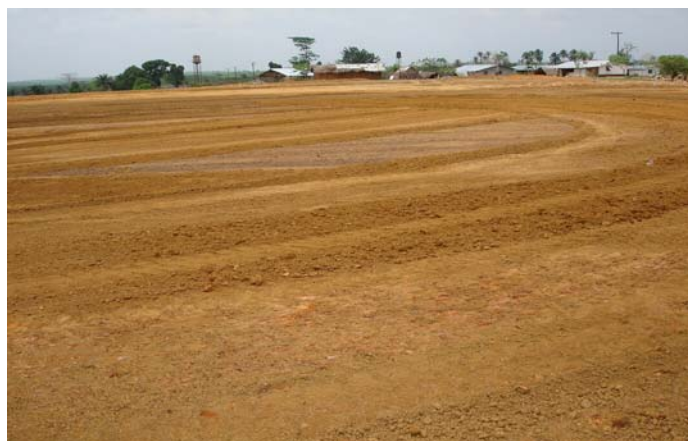
Vorbereitung des Untergrunds für den Einbau eines allwetter-tauglichen Kunstrasenfeldes.
