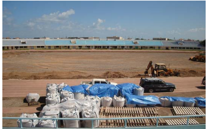
Einbau eines Kunstrasens mit reglementarischen Abmessungen.
