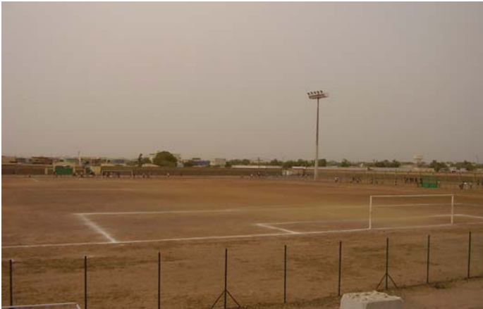
Das Gouled-Stadion vor Beginn der Renovationsarbeiten.
